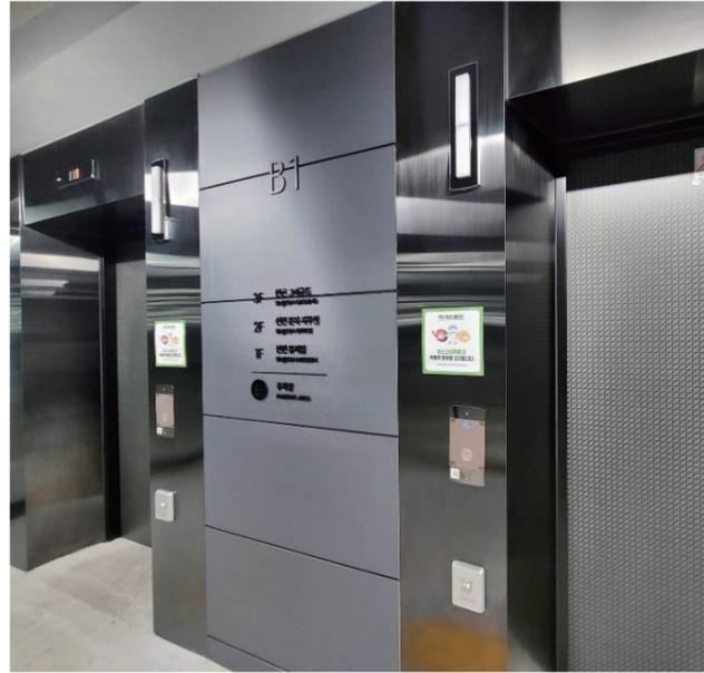
스테인리스 판재를 용액에 침지 시켜, 0.02-0.04 $\mu$ m 두께의 크롬 산화물 층을 형성시키고 산화물 층의 두께 차에 의한 빛의 간섭 작용에 의해서 여러 가지 색을 구현하는 기술입니다.
